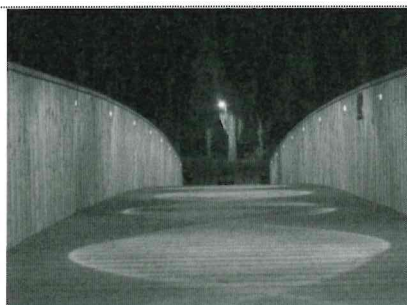
Passerella sul torrente Crostolo Guastalla - RE
