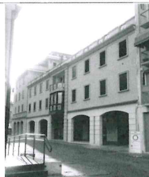
Edificio PR6 Guastalla - RE
