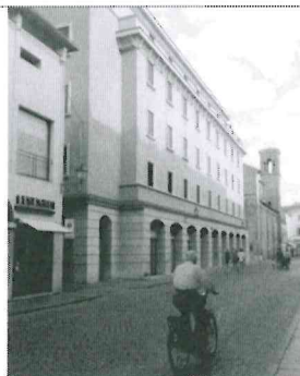
Edificio PR6 Guastalla - RE
