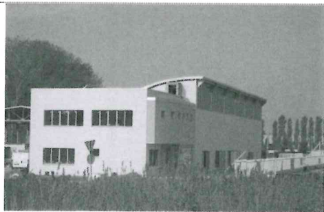
Centrale energetica EVA – En.cor. S.r.l. Correggio - RE
