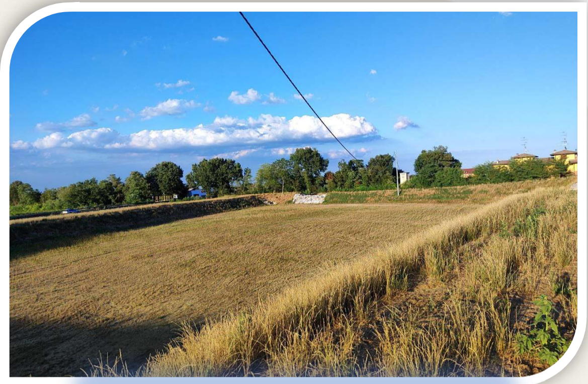
Cassa di espansione Rio Enzola
