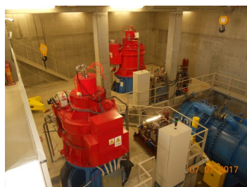
INVASO E CENTRALE IDROELETTRICA - Via S.Michele dei Mucchiotti Sassuolo
