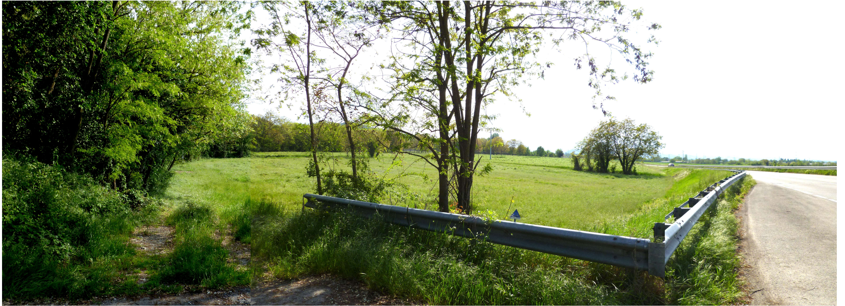
Ripresa n 1 – dal ponte sulla SP23, ripresa ravvicinata dell'area depressa in cui è prevista la cassa di laminazione e, a sinistra, la vegetazione ripariale del Rio
