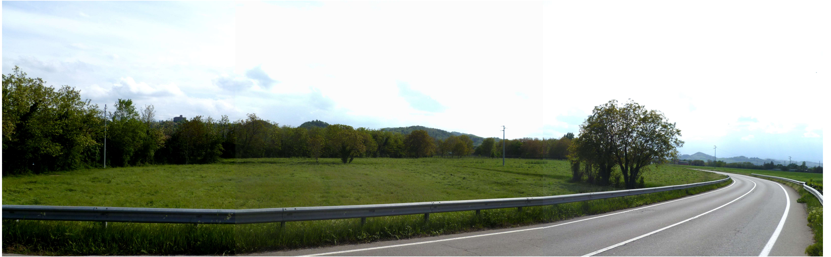
Ripresa n 3 - da nord verso l'area in cui è prevista la cassa di laminazione, più bassa della quota della strada ed oggi occupata da un campo a seminativo
