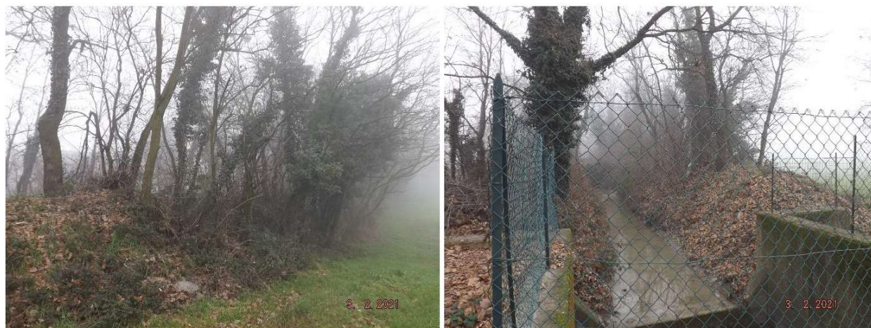
FIGURA 23: ARGINE E ALVEO NEL TRATTO ADIACENTE L'AREA DELLA CASSA DI LAMINAZIONE
