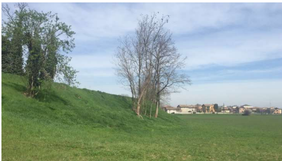
FIGURA 06: L'ARGINE DESTRO DEL RIO ENZOLA A MONTE DI BIBBIANO: SI NOTA LA NOTEVOLE PENSILITÀ SUL PIANO DI CAMPAGNA CIRCOSTANTE
