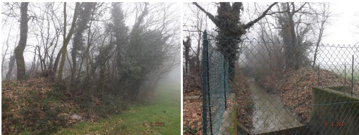
FIGURA 2-2 – RIO ENZOLA: ARGINE E ALVEO NEL TRATTO ADIACENTE L'AREA DELLA CASSA DI LAMINAZIONE
