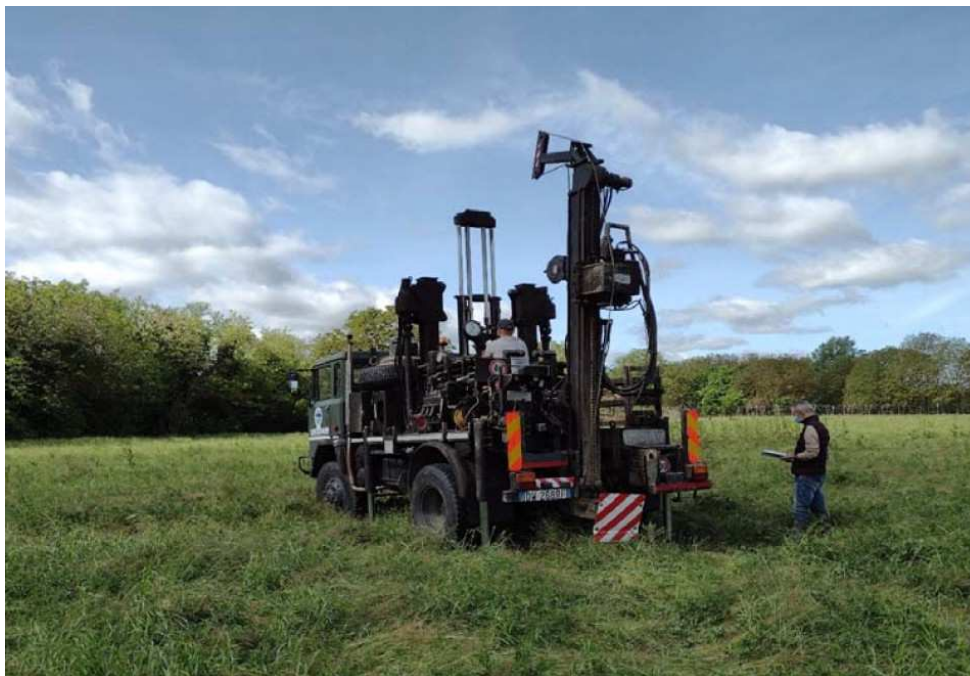
FOTO N° 1 – ESECUZIONE PROVE PENETROMETRICHE STATICHE
