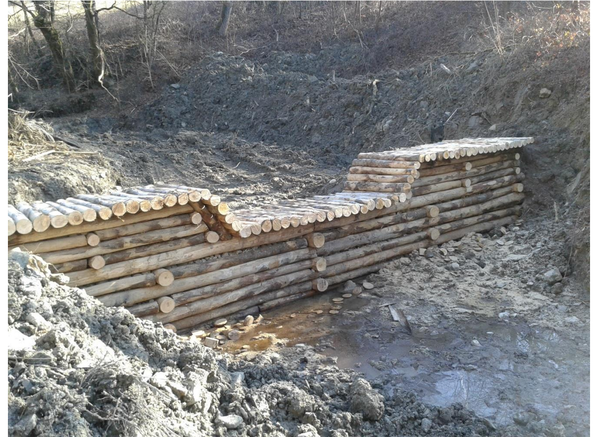
Costruzione di briglia con legname di castagno
