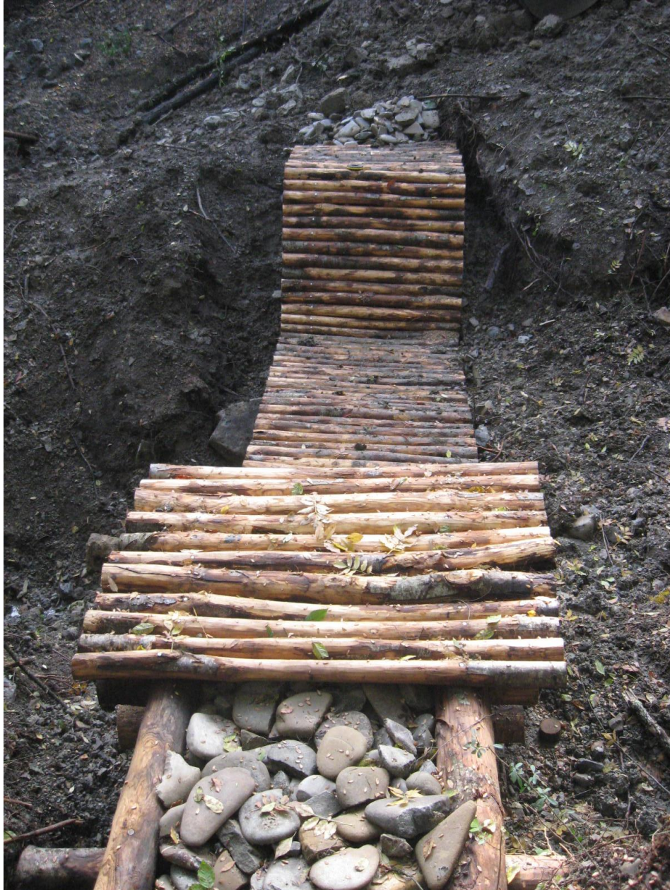
Costruzione di briglie con legname e pietrame e muratura di gabbioni
