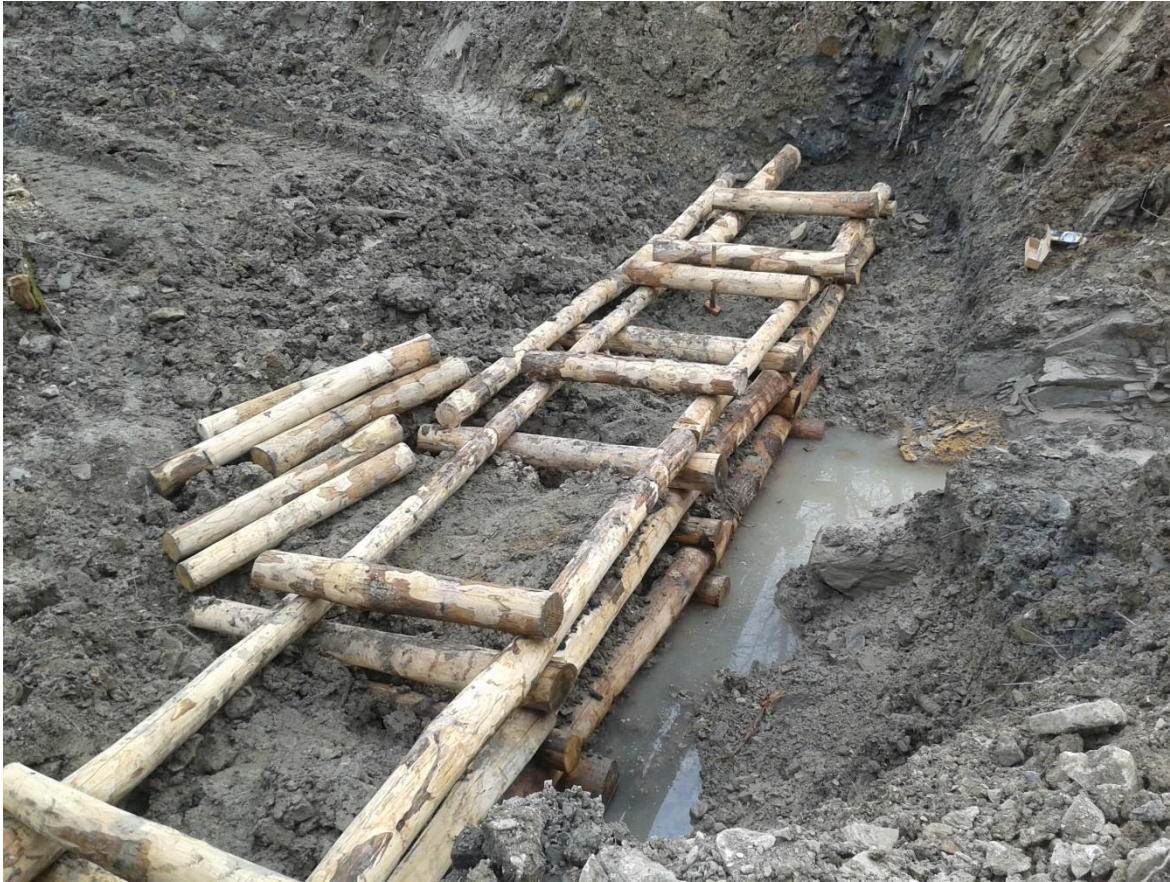
Costruzione di briglia con legname di castagno
