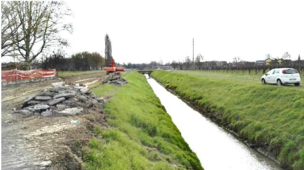
Diversivo Fossa Nuova Cavata prima dei lavori - Posizionamento di una tubazione irrigua in sostituzione del Condotto Gusmea al fine di creare le condizioni per la creazione di una banchina allagabile lungo il Diversivo
