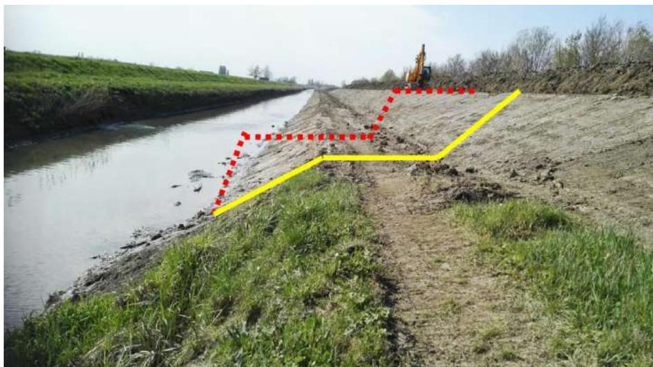
CABM al termine dei lavori di scavo (vista da valle verso monte) (in rosso la sezione originale e in giallo la sezione di progetto, ampliata in termini di profondità e larghezza)
