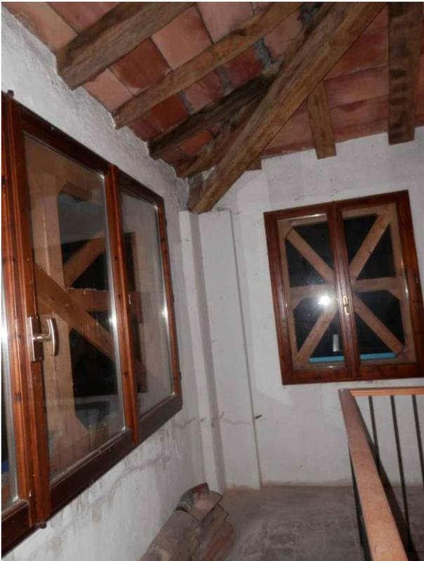
Figura 12 - Vista interna della copertura della torretta con diagonali spingenti sui quattro angoli.
