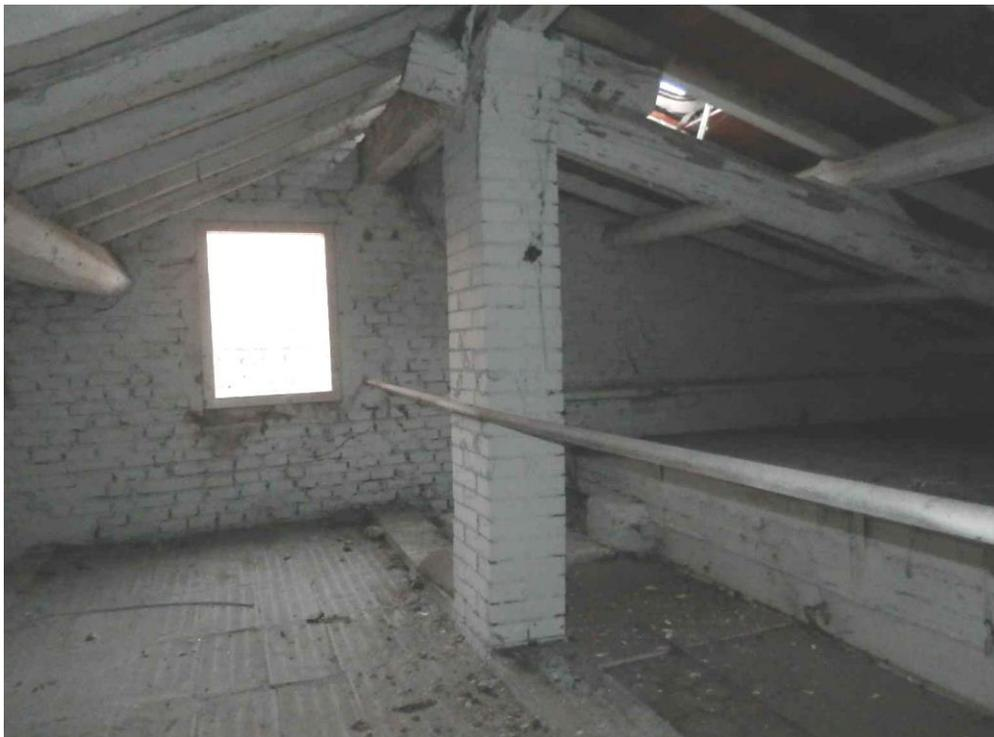
Figura 6 – Pilastro da consolidare.
