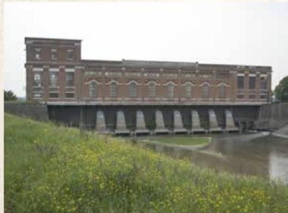
Impianto idrovoro di San Siro
